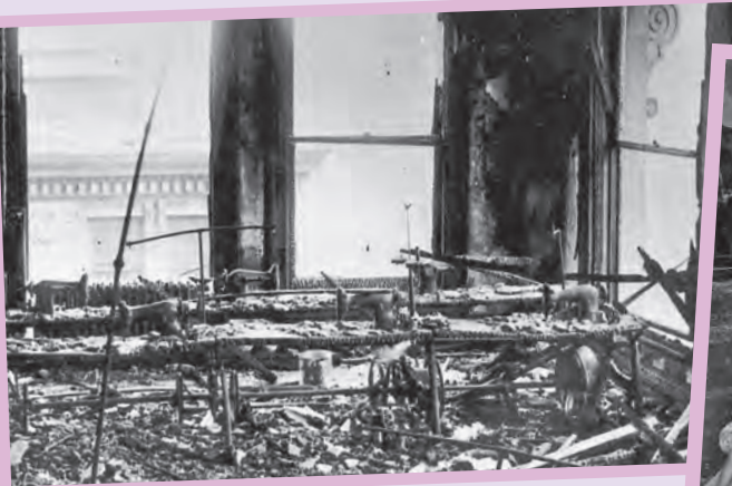
Imagen de cómo quedó el edificio de la fábrica de camisas en 1908, donde murieron más de mil costureras.
