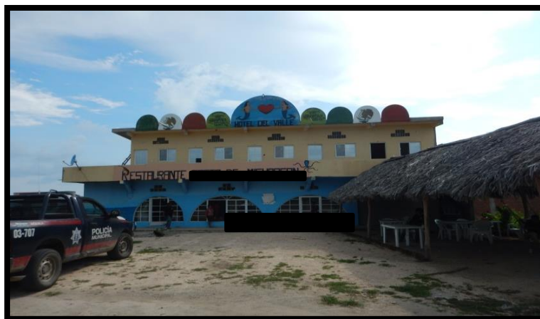
Fachada del inmueble el Restaurante en su primer y segundo nivel.
