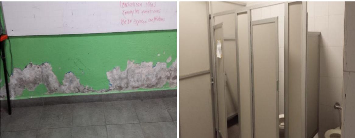
c) La pintura en general está en mal estado, las chapas de las puertas de las aulas de clase no funcionan y existe amontonamiento de mobiliario en desuso en uno de los pasillos del primer nivel y junto a las escaleras principales.
