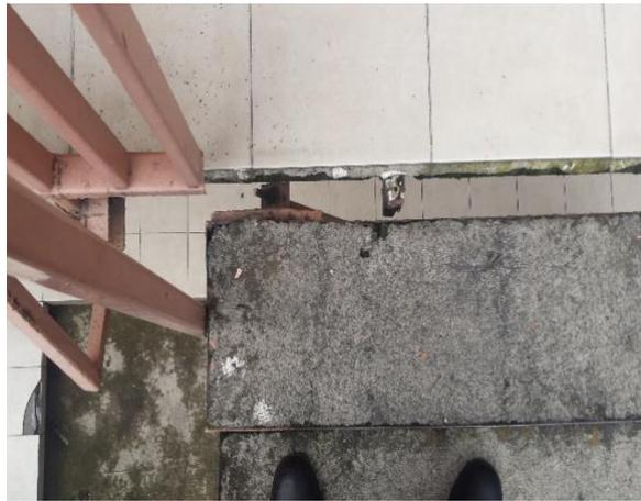
b) Tiene problemas de drenaje ya que en temporada de lluvias se encharca el patio escolar, la cancelería de las ventanas presenta corrosión por el óxido y hay humedad en los techos, así como que presentan desprendimiento de concreto.
