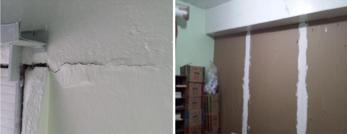
b) Existe humedad en paredes, en los techos existe filtración de agua, algunas de las luminarias no funcionan y algunos sanitarios están fuera de servicio por estar descompuestos.
