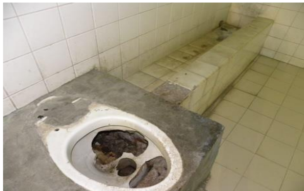
Servicio sanitario del área de mujeres del juzgado calificador del Municipio de Dolores Hidalgo
