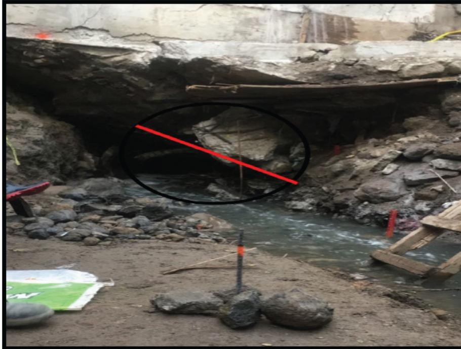
*En el trazo de la línea roja, se observa el material que aplastó el tubo y obstruyó el área hidráulica.*
