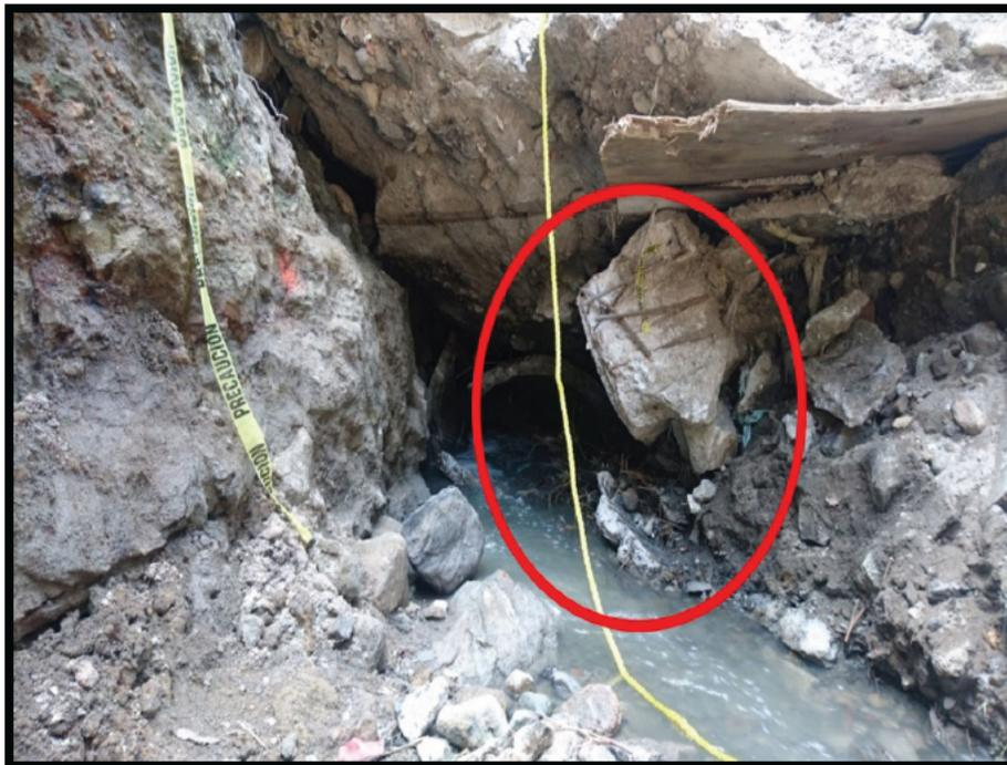
*En la circunferencia color rojo se representó el área original del tubo de concreto de la alcantarilla, la cual después de haber retirado parte de la basura y ramas, permite apreciar el aplastamiento del tubo y la base de concreto de la antigua cámara de video vigilancia.*
