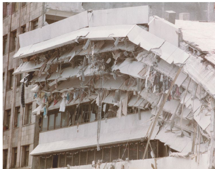
Fábrica de costura colapsada por los sismos de 1985. Ciudad de México. Archivo General de la Nación, AGN. Fondo Terremoto de 1985. Alfredo Hernández.
